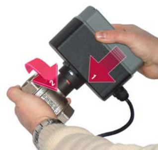
При электрической неисправности питания шаровой клапан может быть открыт и закрыт вручную
